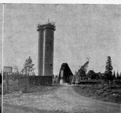
Tre skeden i glidformsgjutningen, som tala sitt tydliga språk beträffande byggnadshastigheten. Bilderna äro tagna resp. den 27/8, den 1/9 och den 5/9.
