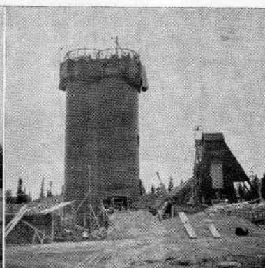
Tre skeden i glidformsgjutningen, som tala sitt tydliga språk beträffande byggnadshastigheten. Bilderna äro tagna resp. den 27/8, den 1/9 och den 5/9.
