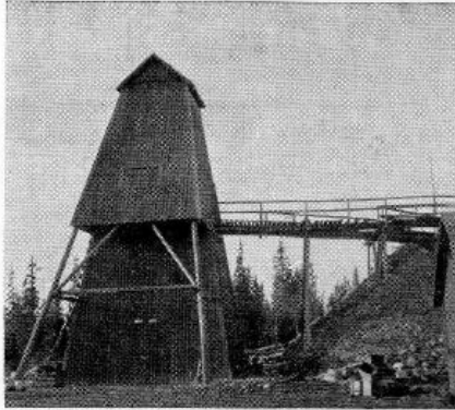
Undersökningslaven före byggnadsarbetets igångsättande.
