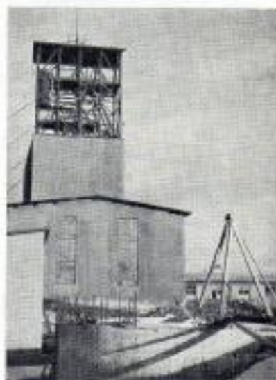
Fundamentet för den nya laven är redan gjutet. Här kommer således den 65 m höga laven att stå.
