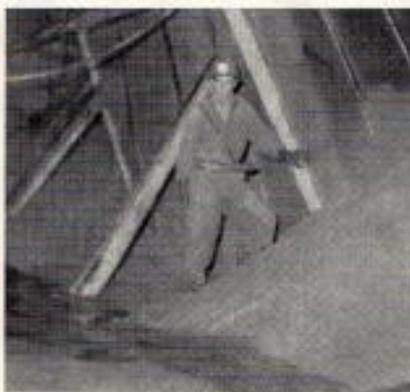
Avfallet låter sig lätt avvattnas genom de timrade och säckvävsbeklädda schakten. Allan Stenberg bevakar att allt går rätt till.
