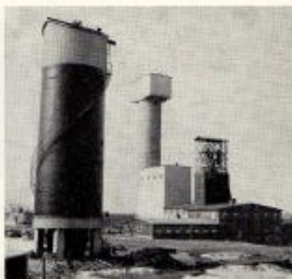
Avfallsfickan under byggnad. Den har givit en ny profil åt Kristinebergs industrionråde.
