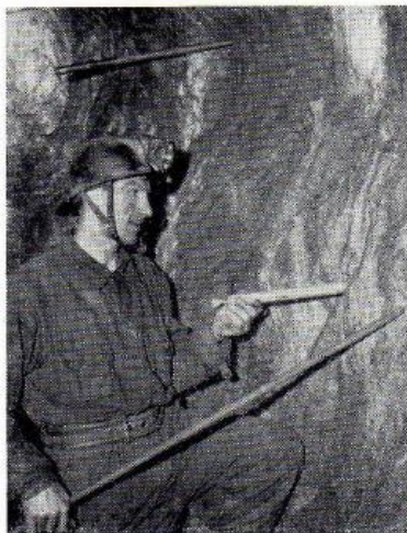
Vid försöken i Kristineberg patronerade bergsingenjör Hans Hamrin AN med hjälp av laddningsaggregat (bilden i mitten). I gruvan mätte Hamrin patronernas längd innan borrarern Erland Jonsson (längst till vänster) laddade salvan.
