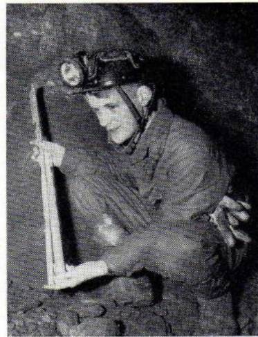
Vid försöken i Kristineberg patronerade bergsingenjör Hans Hamrin AN med hjälp av laddningsaggregat (bilden i mitten). I gruvan mätte Hamrin patronernas längd innan borrarern Erland Jonsson (längst till vänster) laddade salvan.
