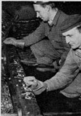
När lyftarna av stål tidigare skulle bytas i en kvarn fick man vara två man för att flytta dem.
