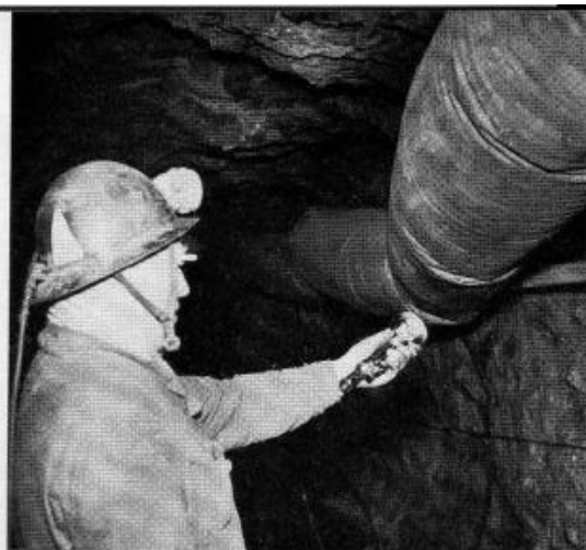
Bekämpningen av dammet följs upp genom ständiga kontroller av luften under jord. Kontinuerliga prov tas med konimeter. Antalet dammpartiklar i det analyserade provet ger ett mått på luftens kvalitet.
