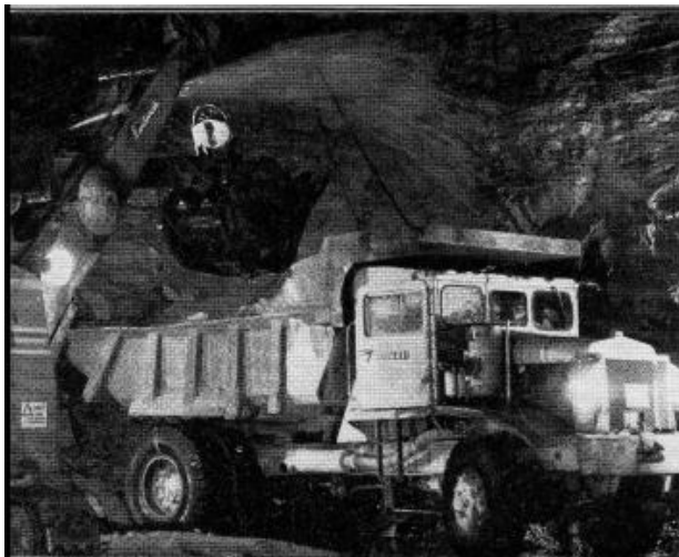
Dammbekämpningen har sedan femtiotalets början varit intensiv i våra gruvor. En allt effektivare ventilation kombinerad med dammbekämpning med vatten har gjort luften bättre och bättre.
